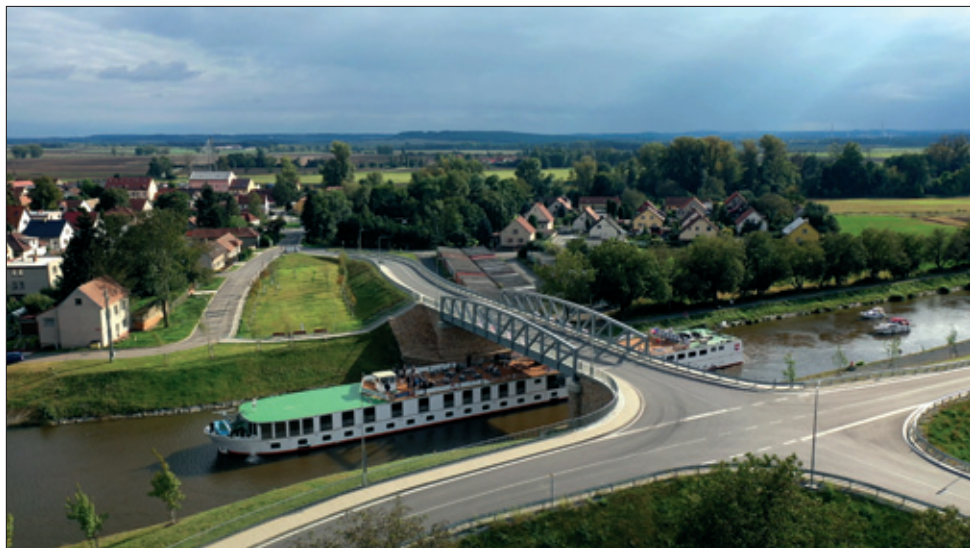
Silniční most Lužec nad Vltavou.
