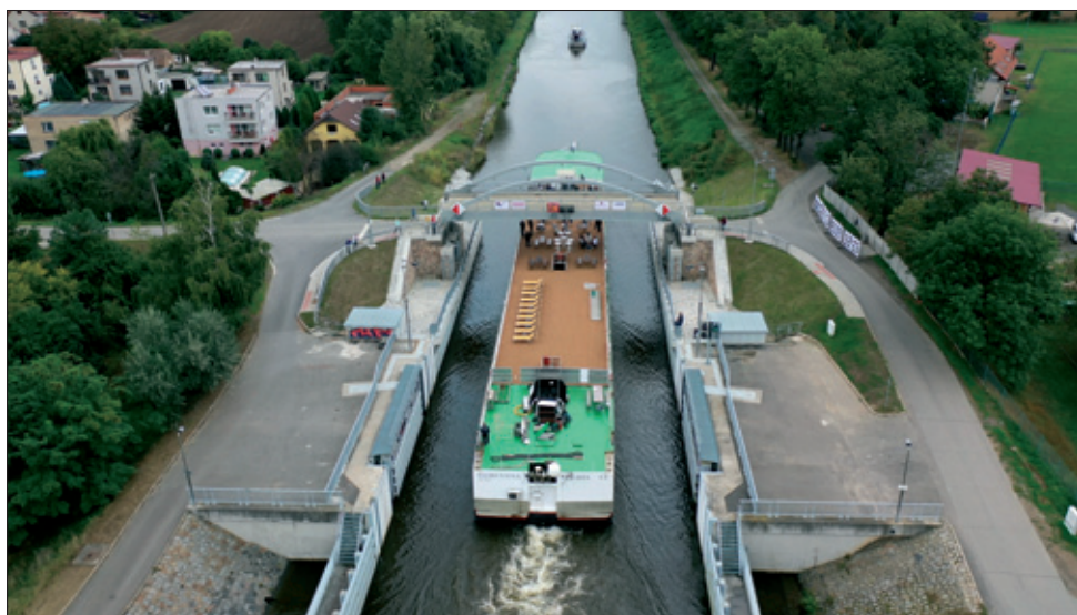
Silniční most Vraňany
