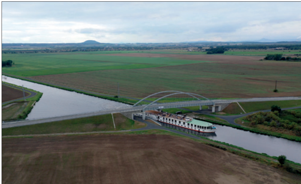
Silniční most Vrbno.
