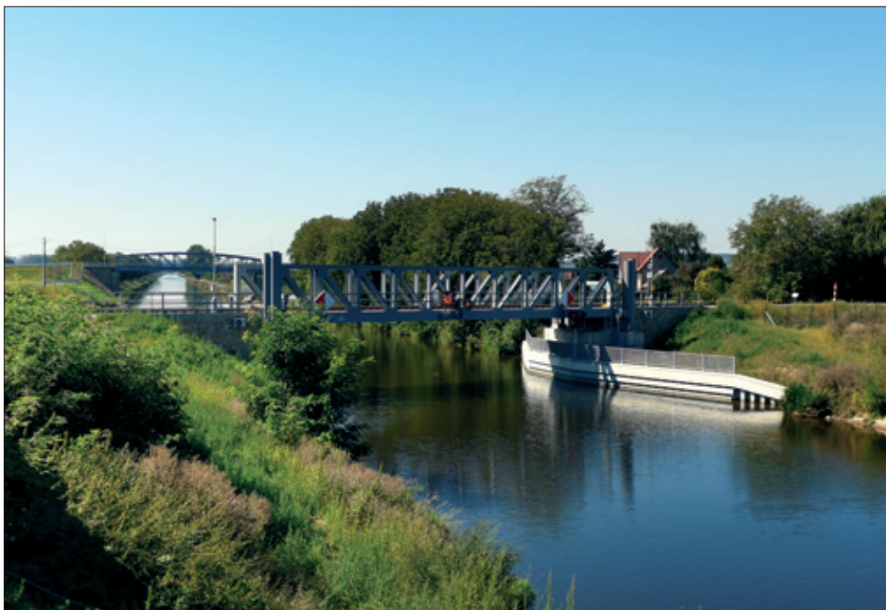
Zdvižný železniční most Lužec nad Vltavou.
