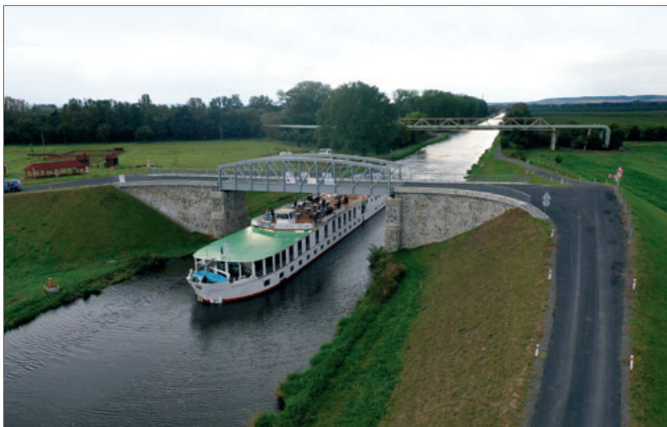
Silniční most Zelčín.
