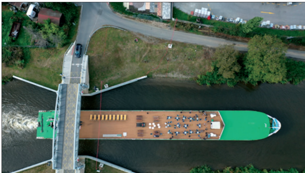
Zdvižený silniční most Lužec nad Vltavou.
